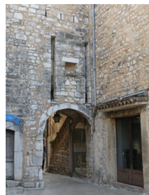
Rainures poutres du pont-levis
