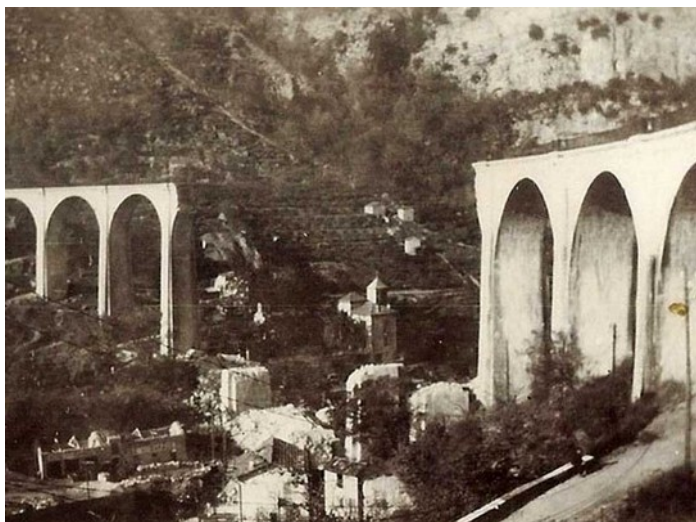
Pont du Loup, détruit par les Allemands en 1944
