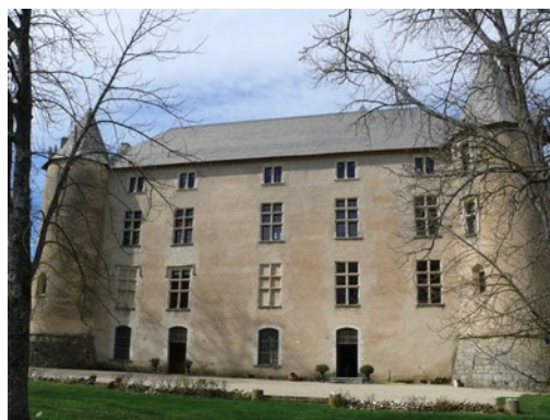
Château (façade Est)
