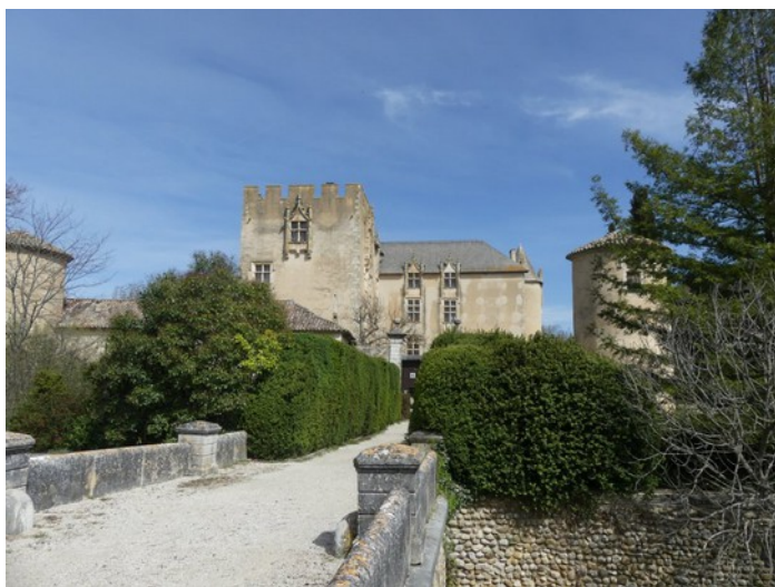
Château (façade ouest)
