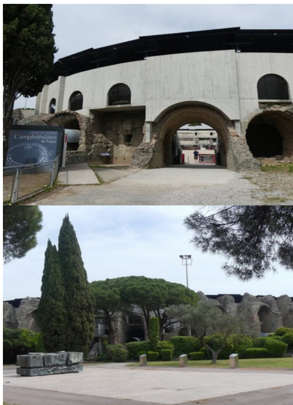
Béton gris et briques romaines
