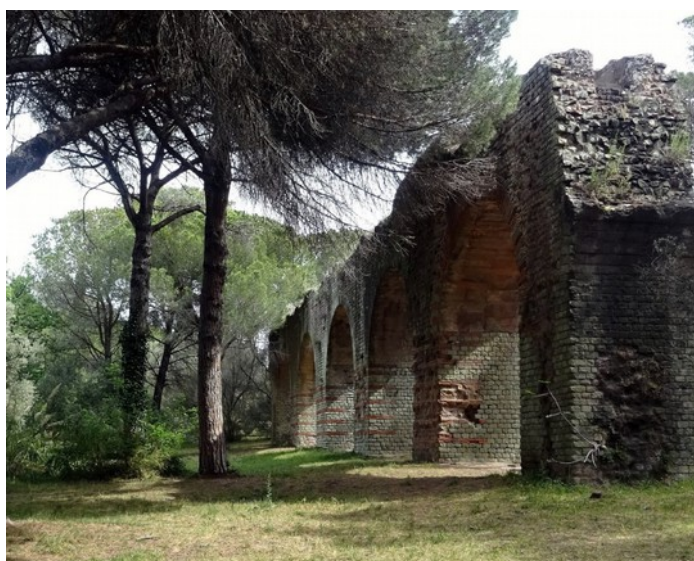
Arches de l'aqueduc romain
