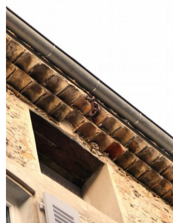
Poulie sous le toit
