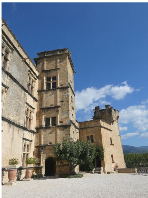
La 2ème tour escalier
