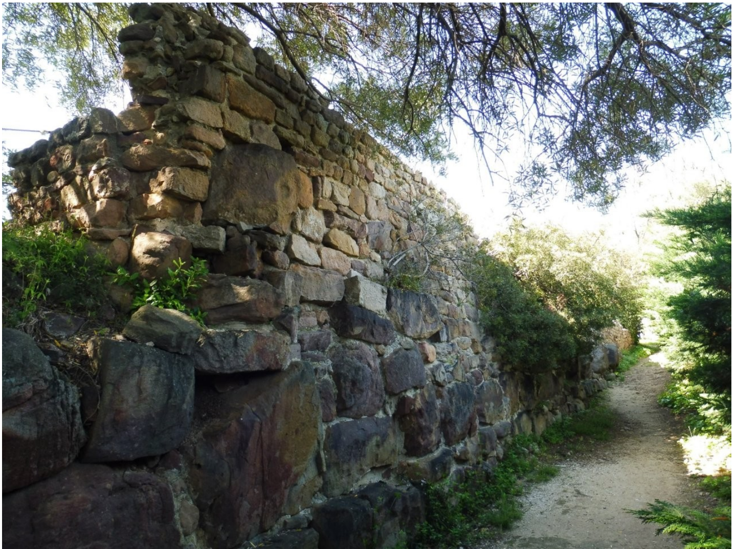
Mur d'enceinte Est
