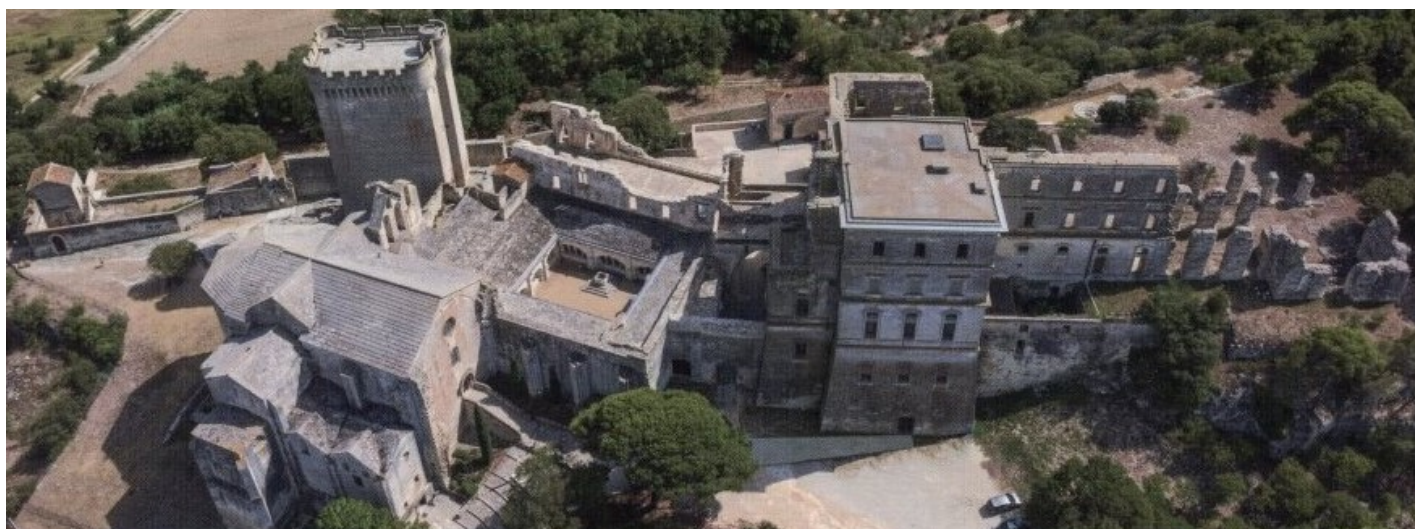
Abbaye de Montmajour vue aérienne Nord
