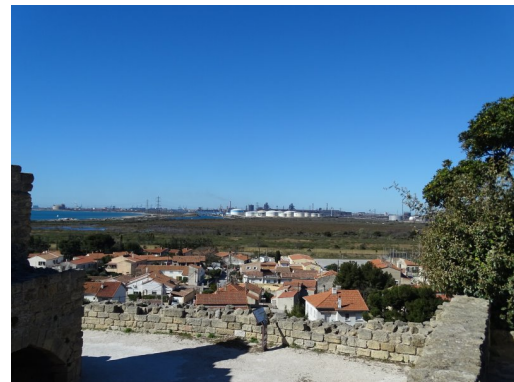
installations pétro- chimiques
