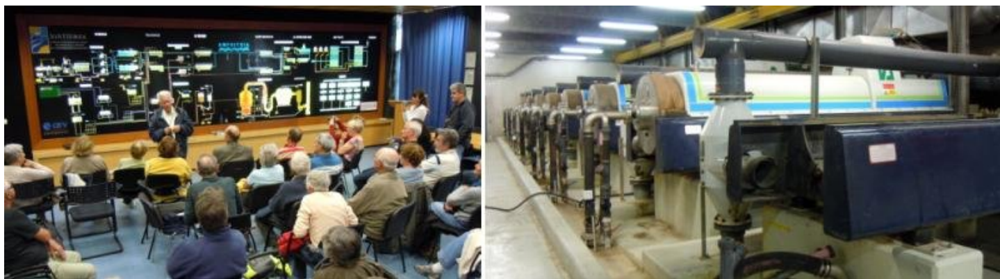
A gauche, notre groupe dans la salle de réunion ; à droite la salle de déshydratation des boues...
