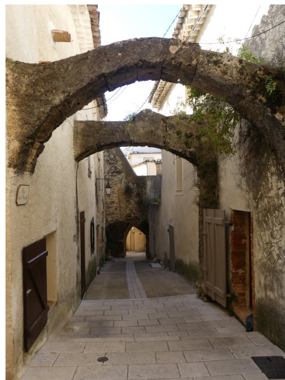
Passage voûté et ses arcades
