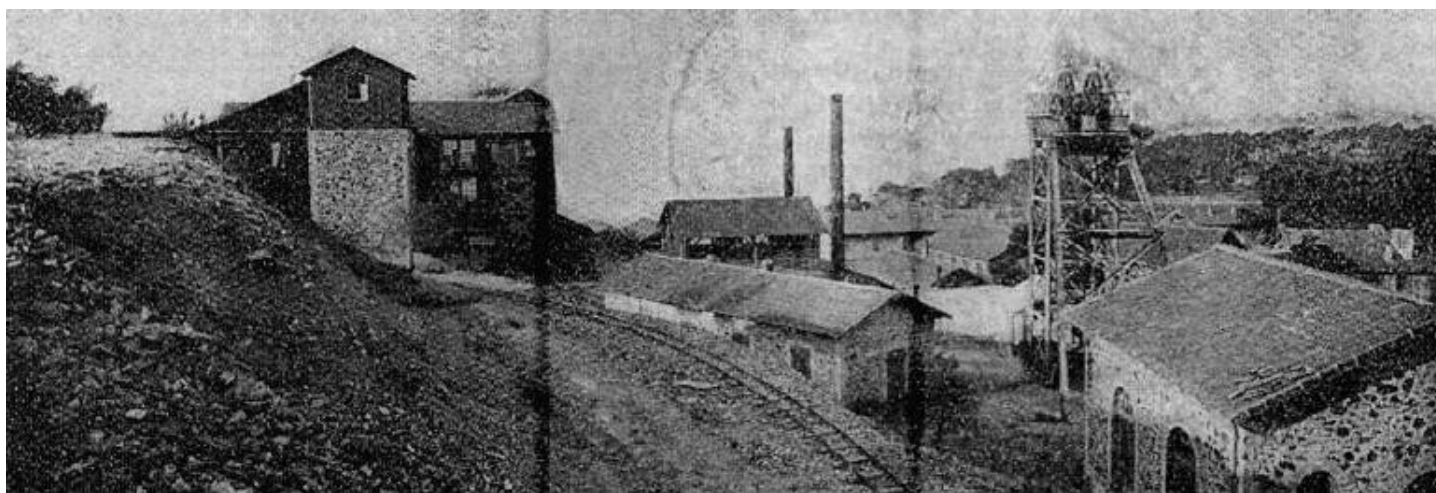
La voie ferrée à proximité de la sortie des deux puits au dessus de la plage de l'Argentière
