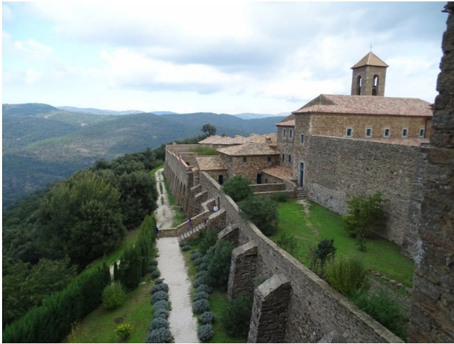
Vue sur l'église et les hermitages
