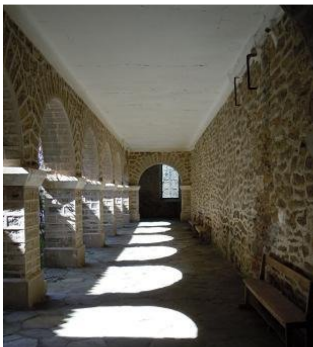
Deux galeries permettent l'accès à l'église
