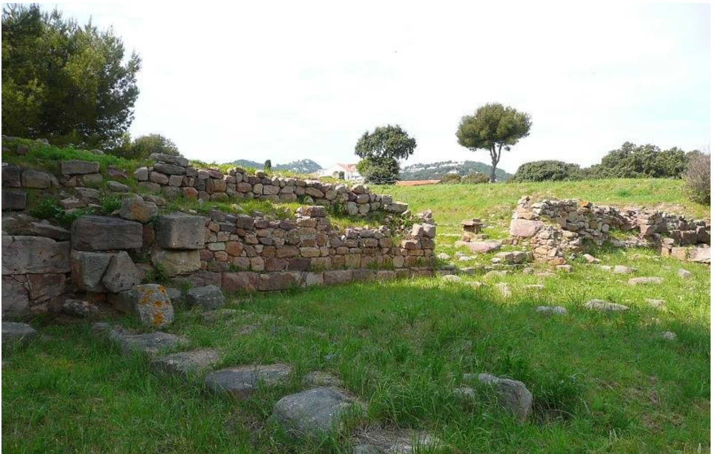
Entrée unique et usure du pavement
