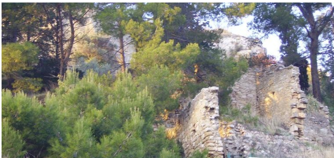
Des ruines de 1909 sont encore visibles dans la partie haute de Rognes
