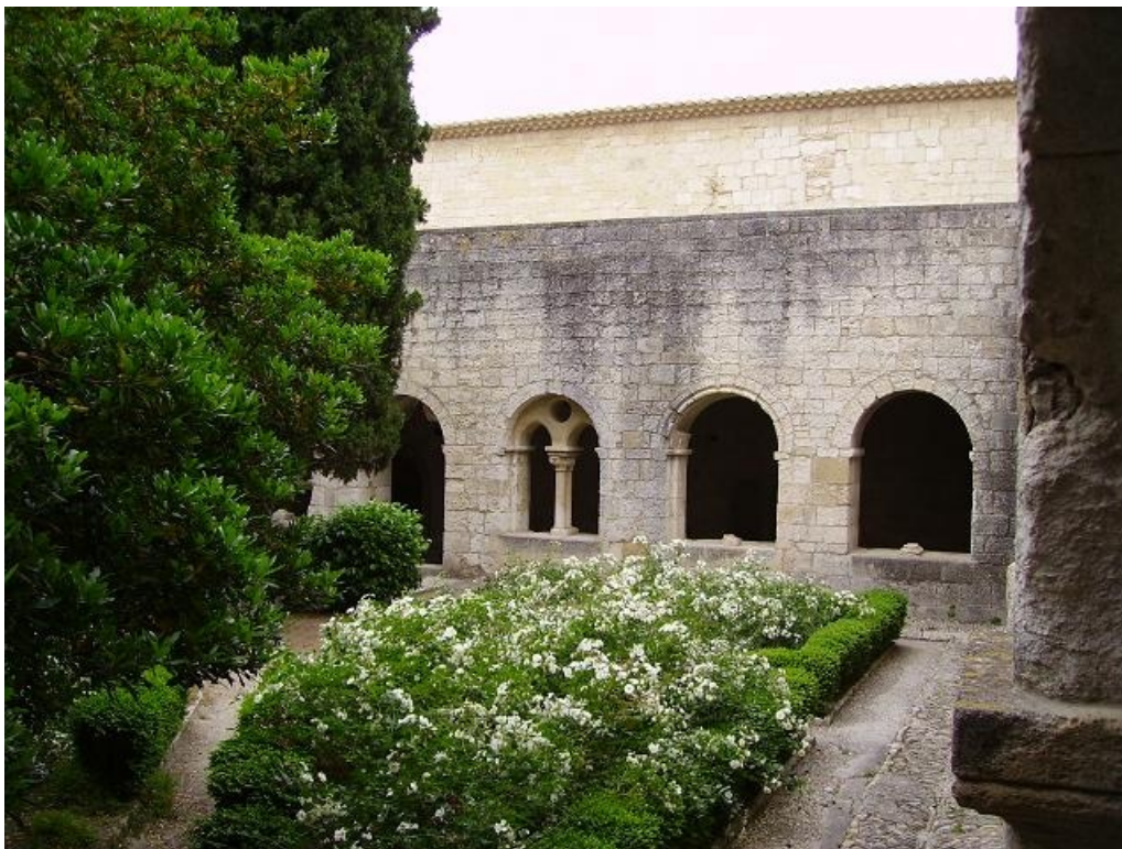
Toutes les ouvertures avaient été détruites – Seule l'une d'elles est restaurée.
