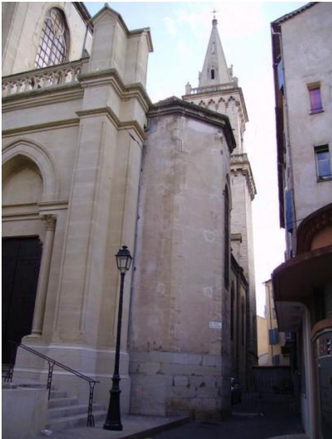
Malgré l'effet de perspective, on voit que la tour du clocher penche dangereusement. Observez à droite la voûte tronquée et remplacée par une charpente en bois plus légère.
