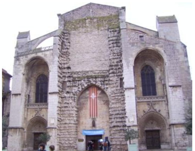
La façade inachevée de la Basilique de Saint Maximin la Sainte Baume construite de 1295 à 1532. Longue de 73 m, large de 37 m et haute de 28 m, la basilique est le seul bel exemple de style gothique en Provence.
