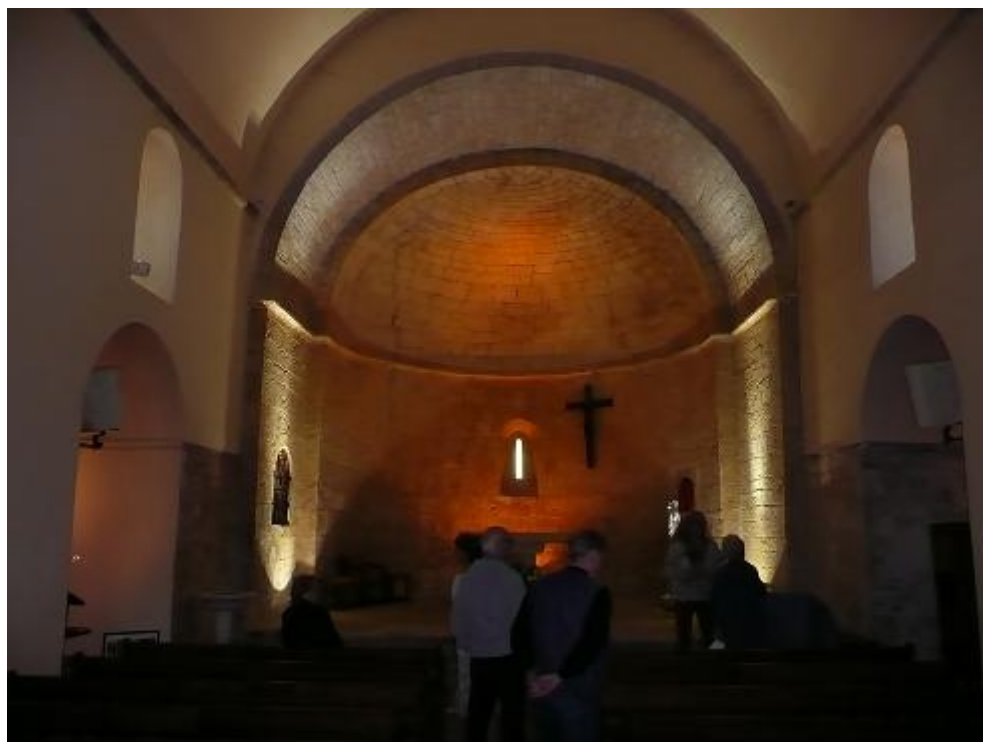
... est constituée d'une seule nef que recouvre une voûte romane à berceau
