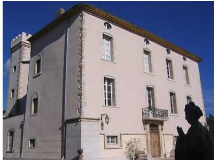
La façade principale du château orientée au sud
