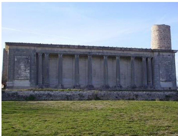
Façade est avec péristyle de 10 colonnes doriques
